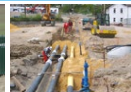
Medientrassen Fernwärme
